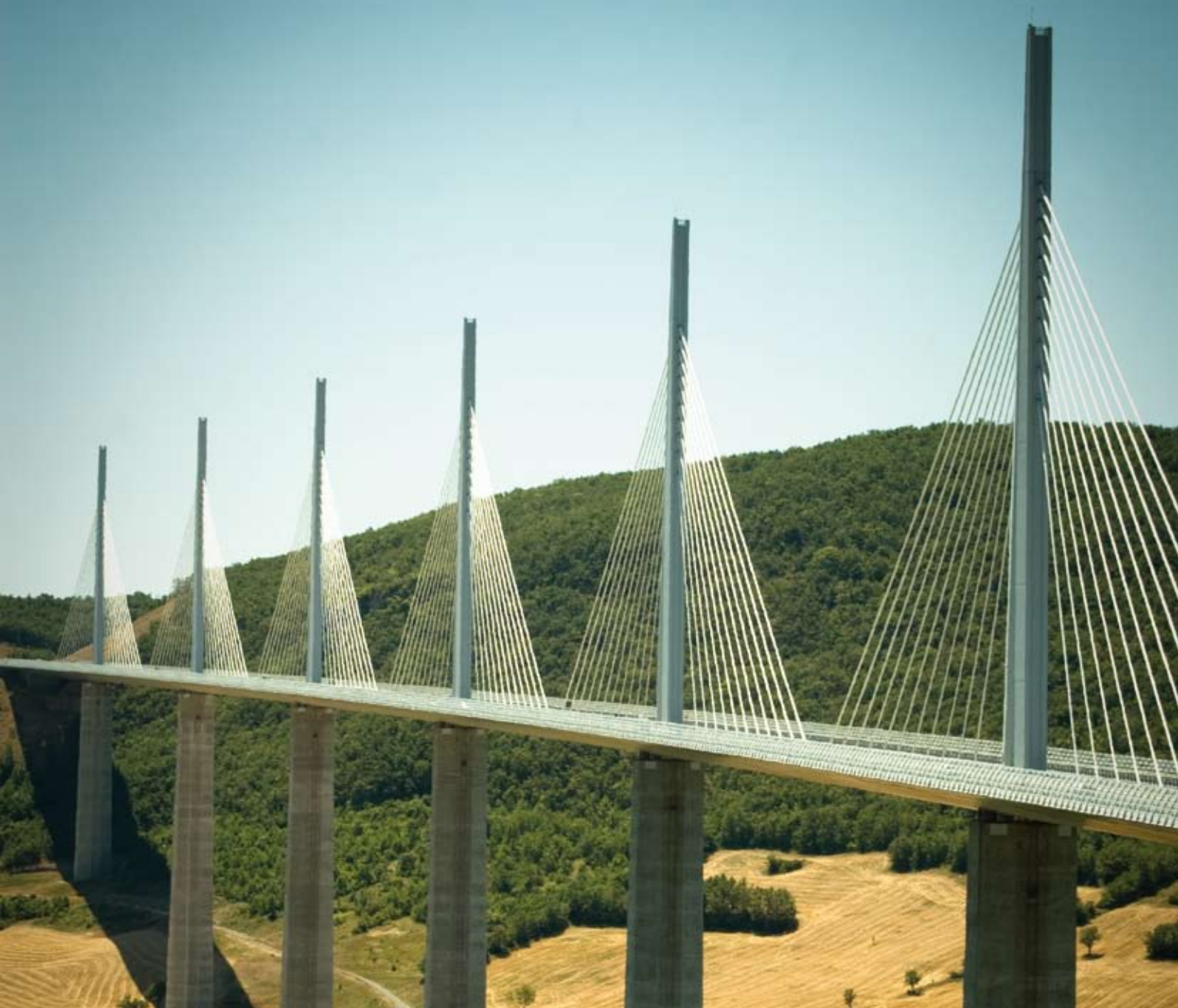
Språk åpner dører... og bygger broer! Le Viaduc de Millau stod klar i desember 2004 og knytter nord og sør tettere sammen i Frankrike. Broa er høyere enn Eiffeltårnet. Kilde: Eole, http://www.flickr.com/photos/eole/3840223627/sizes/l , CC-lisens: http://creativecommons.org/licenses/by-nc-sa/3.0/
